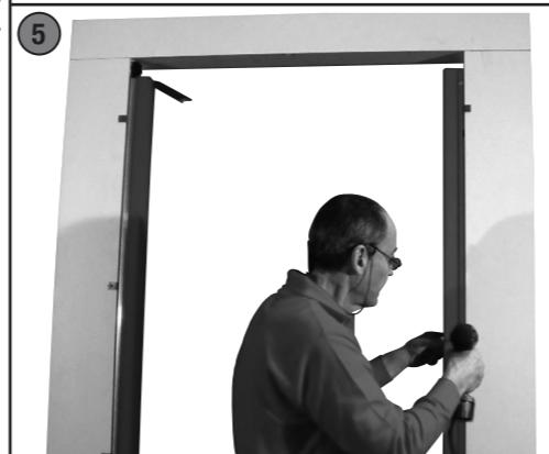
① 3-Fissare il montante lato cerniera, tramite le zanche al falso telaio. Verificare allineamento con il filo a piombo.
